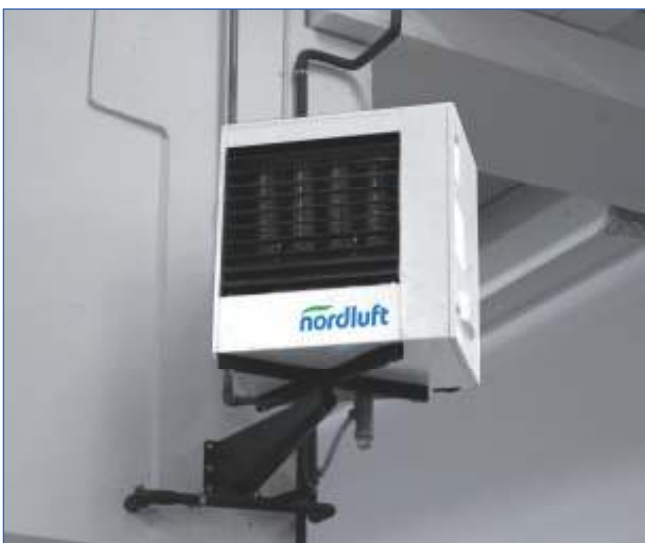
Gasatherm G-30 auf drehbaren Wandkonsolen (Sonderzubehör) und Kondensatablauf.
