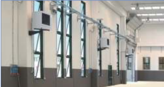
Installation von Gasatherm K-45 auf drehbaren Wandkonsolen (Sonderzubehör).
