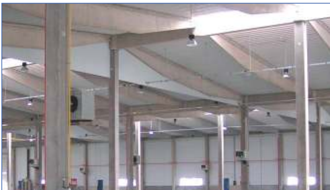
Installation von Gasatherm G-60 mit Kondensationsbetrieb für Wirkungsgrade bis 105%.
