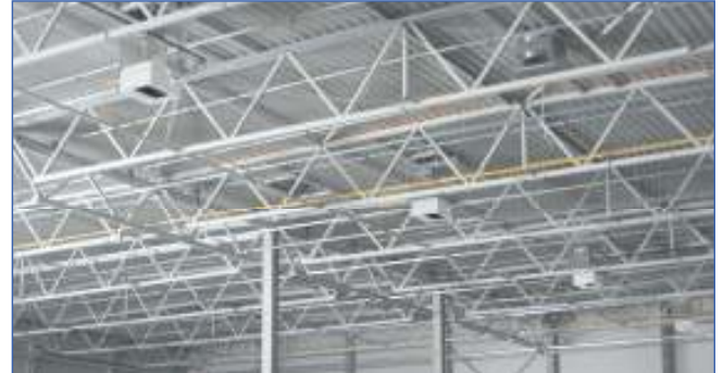
Deckenmontage von Gasatherm F-60. Systemvorteil: Wärmerückführung aus dem Deckenbereich durch die Geräte.
